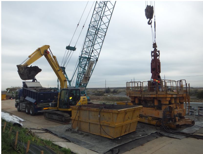
写真 3-1 ハンマーグラブによる掘削状況及びハンマーグラブ本体の写真
