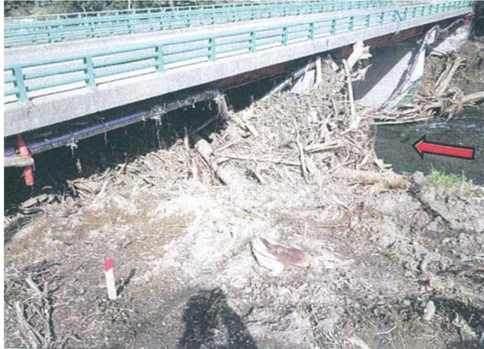
土砂等の埋そく状況の例
