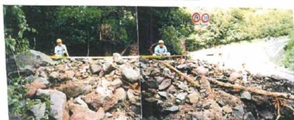
崩土の横断形がわかる写真の例
