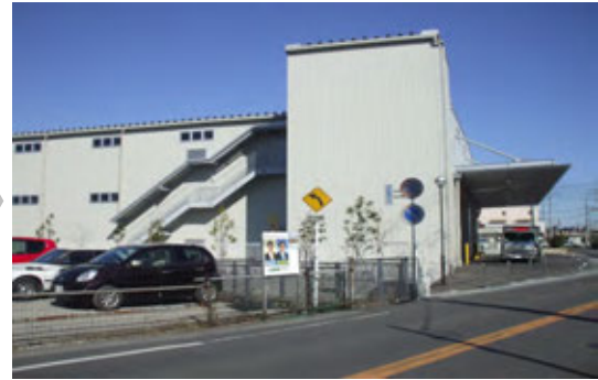
写真Ⅲ-2 現況。倉庫建築済み。
