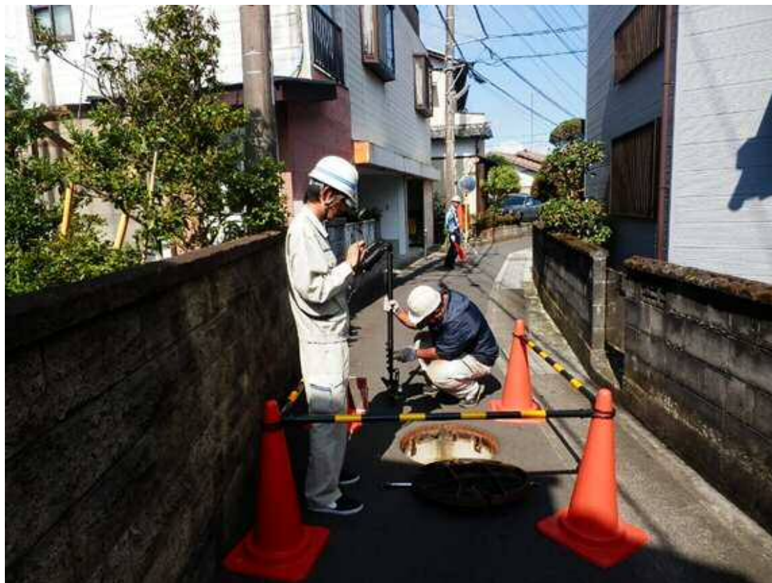
管口カメラ点検実施状況
