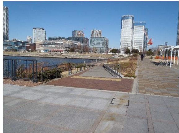
対象岸壁に下りるスロープ
