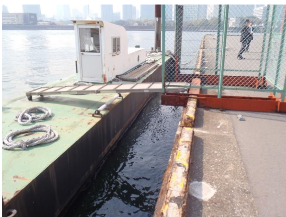
ポンツーンとアクセス橋
