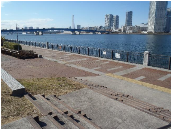
対象岸壁（上方から撮影）
