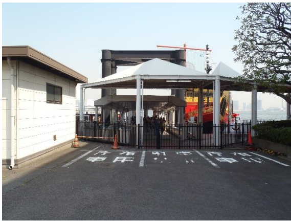
LNG ローリー駐車位置（想定）から見た ポンツーンへのアクセス橋のゲート
