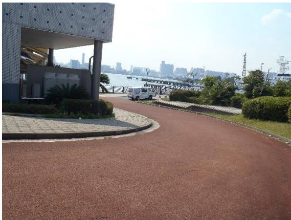
LNG ローターのアクセス路② ※左の建物は青海客船ターミナル
