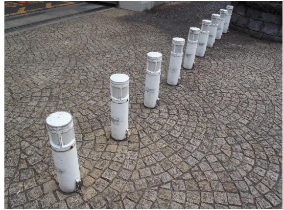
ゲートに設置された車止め
