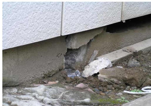
図2 地震時の開口部の被害
