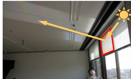
採光フィルム+内ブラインドの事例 (入射太陽光を天井へ導入)
