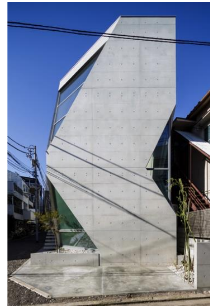
竣工した住宅
