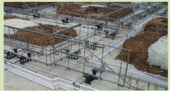
[住宅用基礎の配筋状況]
