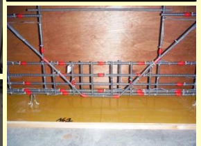
布基礎の配筋
