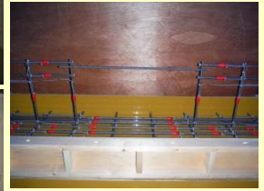
べた基礎の配筋
