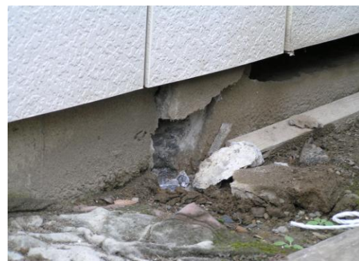
図2 地震時の梁貫通部の被
