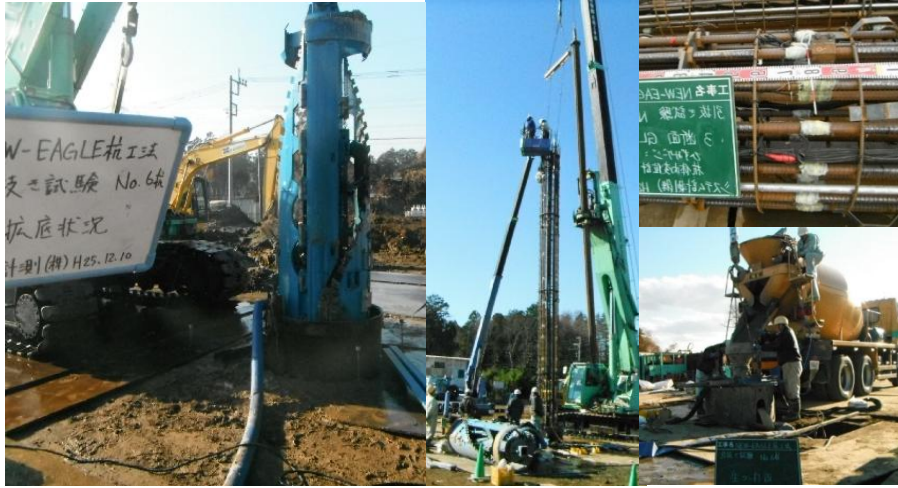
① 載荷試験杭施工
