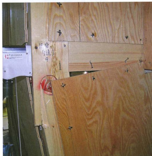
南面隅の通り柱が曲げ破壊した様子。合板がパンチングシア現象(合板が割れ、くぎが合板を突き抜ける現象)を起こし、はがれている。建物全体が復元不可能なところまで変形すると、2階の荷重がのしかかるように1階を壊す
