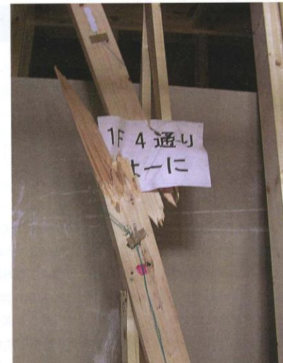
座屈した筋交い。圧縮方向に力がかかると大きく変形して折れてしまう。この部分が石膏ボードで覆われていると、ボードが座屈止めとなって座屈しにくくなるが、この実験ではボードが脱落し、筋交いの座屈を拘束する効果が得られず、こうした被害も出た
