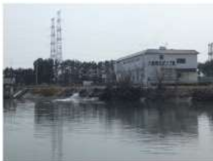
仮設ポンプによる排水
