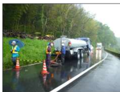
流域下水道マンホールへし尿投入
