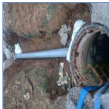
別幹線MHへ仮設管を布設
