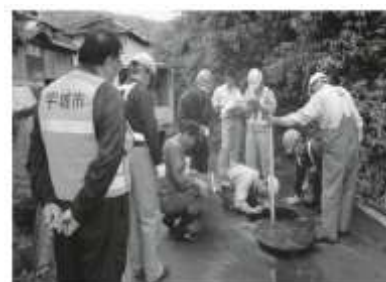
マンホール調査(宇城市)
