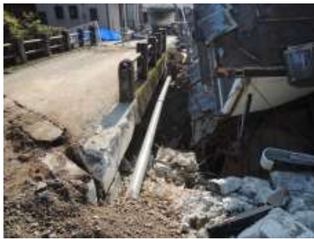
橋に番線で懸架した仮設配管
