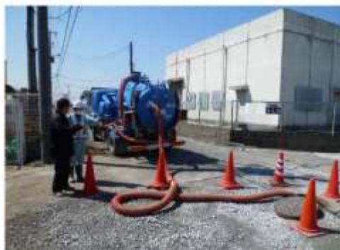
汚泥吸引車による吸引状況
