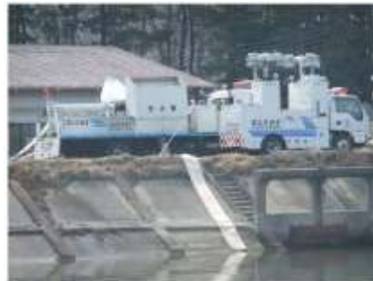
移動ポンプ車による排水
