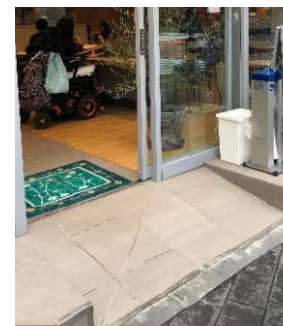
スロープの設置
