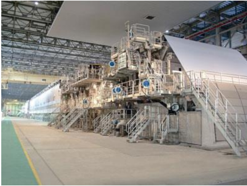
図 8 日本製紙株式会社石巻工場に設置されている抄紙機
