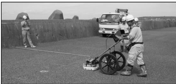
長寿命化計画策定に必要な空洞化調査の事例
