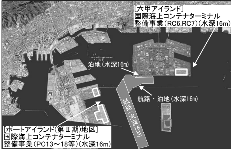
神戸港実施中プロジェクト（平成29年度）
