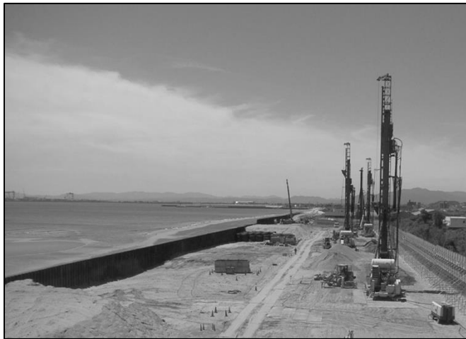
海岸堤防の液状化対策：津松阪港海岸
