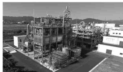
静岡市中島浄化センター 固形燃料化施設
