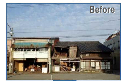
空き家の除却
