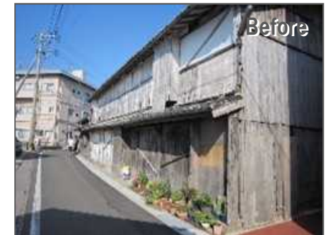
空き家の除却
