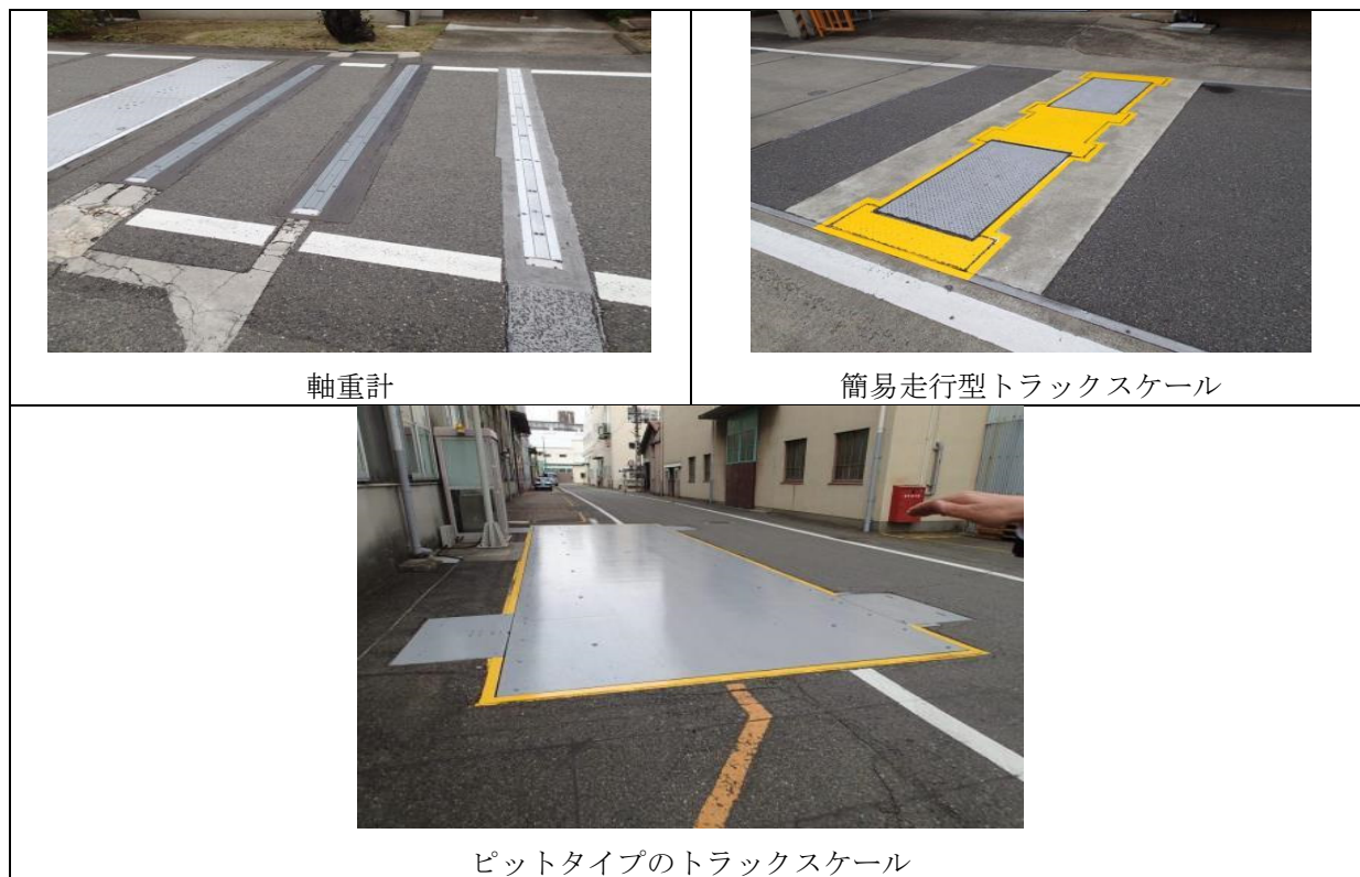
図 7-20 工場内のトラックスケール
