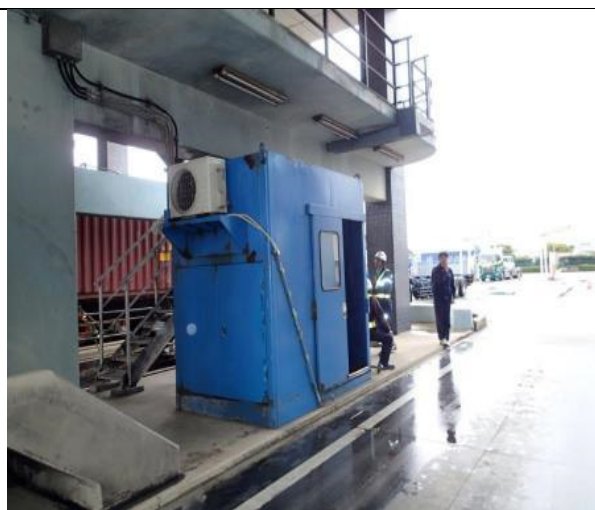
ゲートに設置されているトラックスケール (注. 現在使用されていない)
