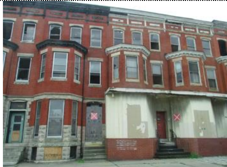
開口部封鎖（ボードアップ）された連棟住宅□ Baltimore, photo by Yasuyuki Fujii, 2016□
