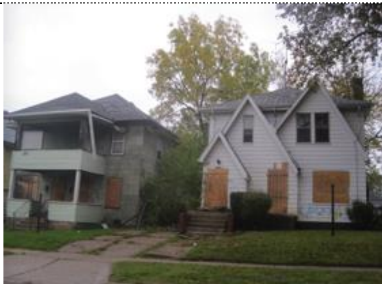
開口部封鎖（ボードアップ）された空き家□ Flint, photo by Yasuyuki Fujii, 2013
