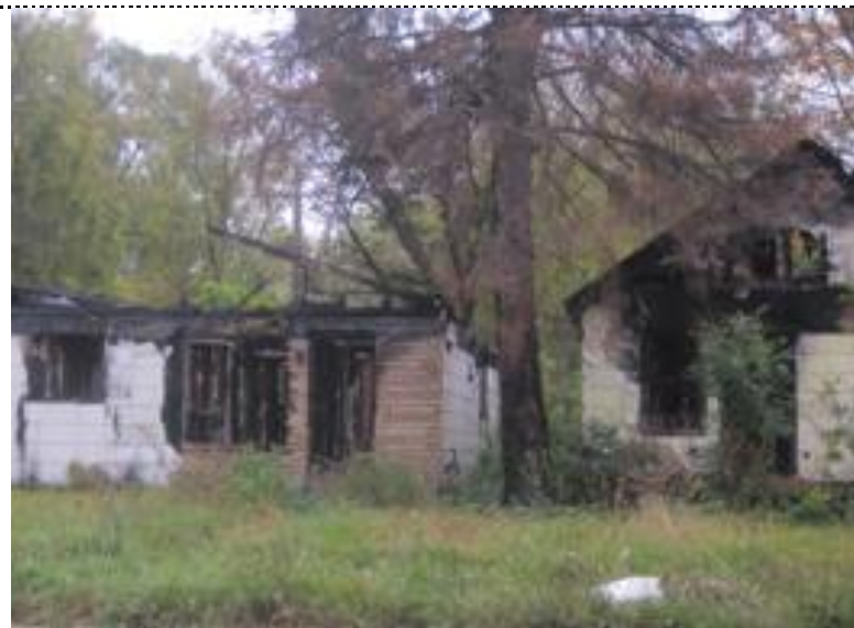
放火にあったとみられる空き家□ Detroit, photo by Yasuyuki Fujii, 2013□
