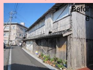
空き家の除却
