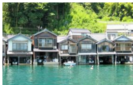
舟屋をカフェ・宿に改装して運営 (伊根 油屋の舟屋「雅」)
