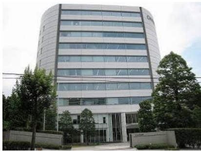
カルピス本社。横に連なるガラス窓とプレキャスト版を組み合わせて、ガラス面の割合を抑えた。窓の位置を外壁より少し後退させている
