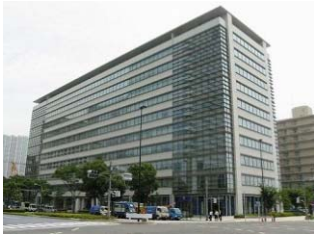
晴海センタービル
