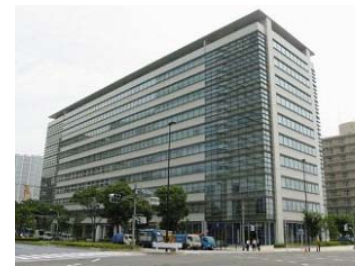
晴海センタービル。設備5分野のうち、照明について、仮想値に対して7割以上低減
