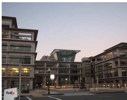
図 1-15 CalPERS 本部ビル (LEED Gold)
