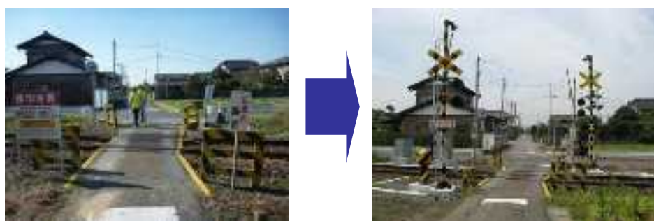
図20：踏切遮断機・警報機の整備
