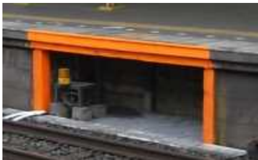
ホーム下の待避スペース
