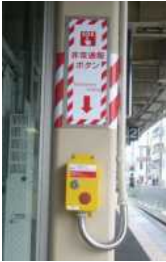
非常停止押しボタン
