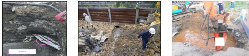
工事に伴う埋設物の損傷事故
