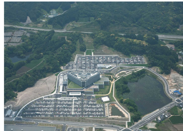
写真—中東遠総合医療センター外観
