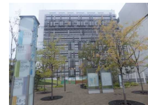
写真一スマートエネルギーセンター外観
