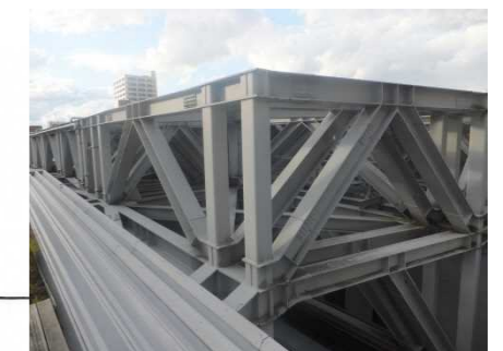
写真—鉄骨屋根
