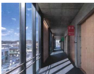
写真二、3階西側廊下
