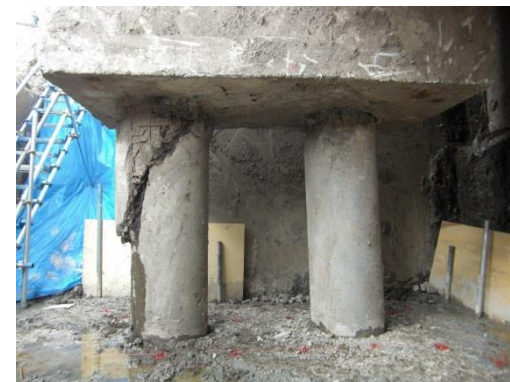
熊本地震での杭被害
