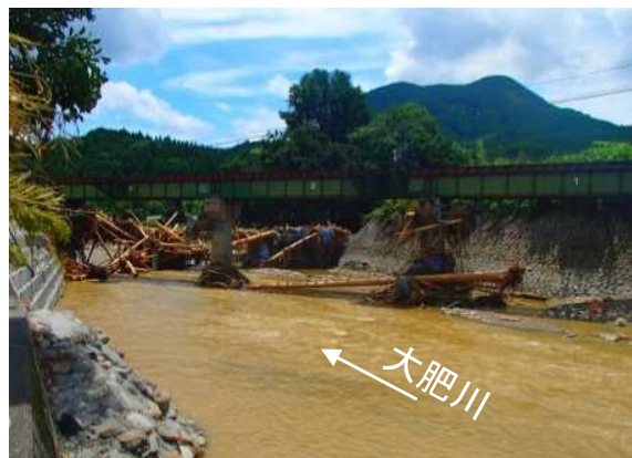
① JR橋、市道橋の流木による閉塞状況
