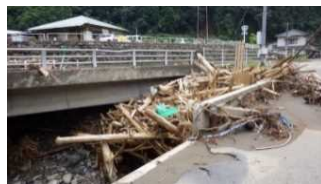
橋梁に集積する流木
