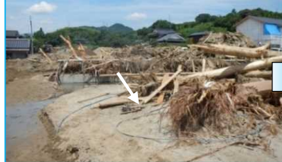
赤谷川（緊急復旧） 整備前
