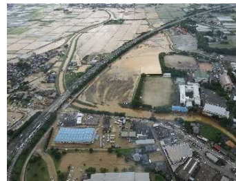
桂川における浸水被害
