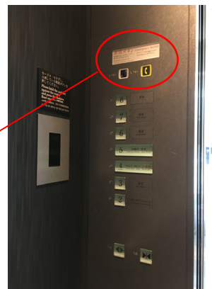
B エレベーター内の非常ボタン 聴覚障害者が耳マークのボタンを押し続けると、係員が来るようになっている。
