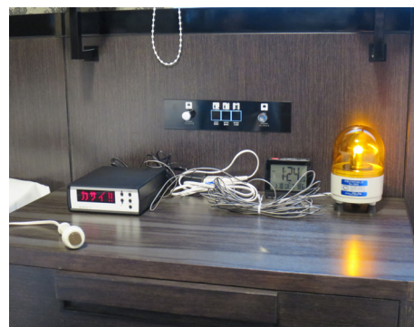
・緊急通報ボタン（左）と、従業員からの電話連絡に反応し、文字情報や光で火災等の発生を伝える装置
