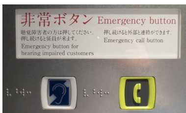
B エレベーター内の非常ボタン 聴覚障害者が耳マークのボタンを押し続けると、係員が来るようになっている。
