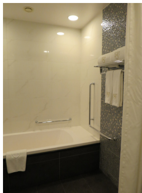
・移乗台及び手すりを設けた浴槽
