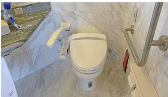
・両側に手すりを設けた便所
