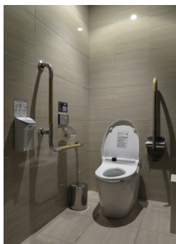
E 一般トイレ (女性) の便房 両側手すりが設置された広めの便房が設けられている。
