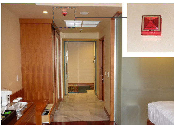
・車いす使用者の利用に配慮した幅員を確保した通路（出入口は引き戸、コンセントは床から約30cm、スイッチは約1mに設置。天井には聴覚障害者への情報伝達のための非常表示灯を設置）
