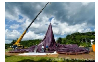
設置中の様子
