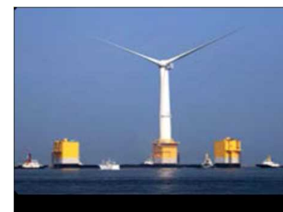
浮体式洋上風力発電
