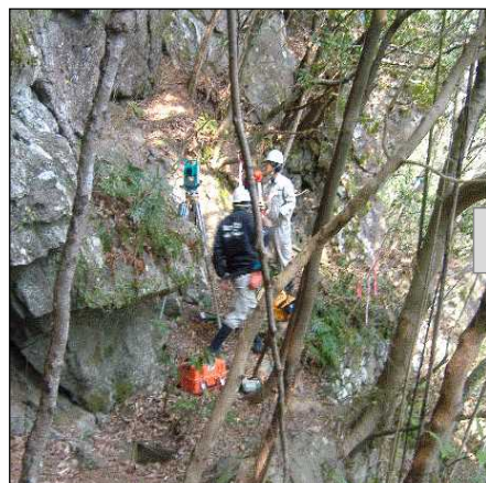
現地立会により、土地所有者等が現地で土地境界の位置を確認
