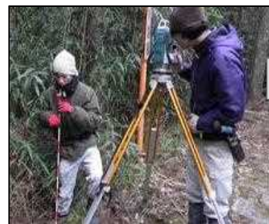
土地の境界点について、現地に測量機器を設置し、1点毎に座標値の測量を実施
