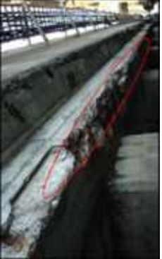
コンクリートの剥離、鉄筋腐食
