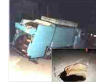
下水道の老朽化による道路陥没
