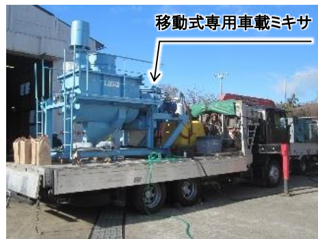
専用車載ミキサによるスリムクリートの練混ぜ
