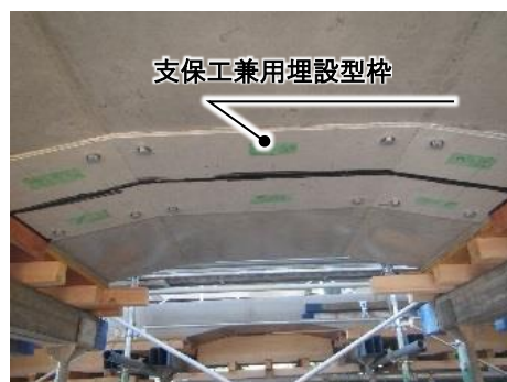
支保工兼用埋設型枠の使用状況
