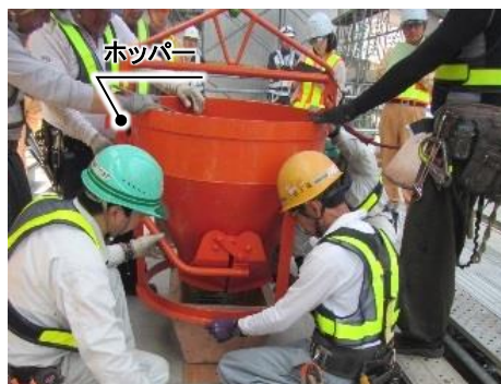
ホッパーによるスリムクリート打込み
