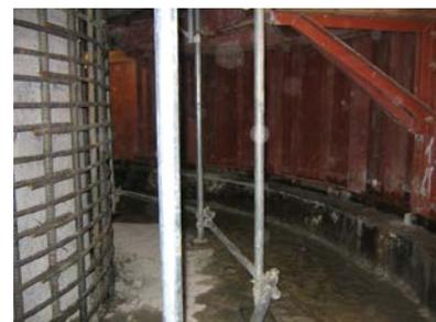
ドライアップ時の仮締切内部状況
