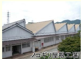
ノコギリ屋根工場
