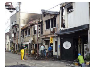
火元建物付近の様子
