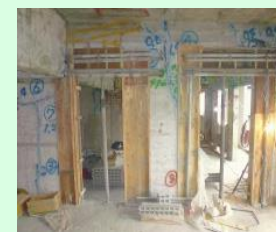
内壁等の補強
