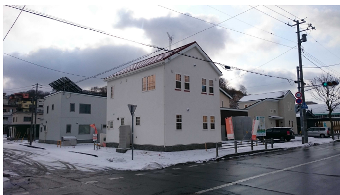
各戸に家庭用燃料電池を整備した街区
