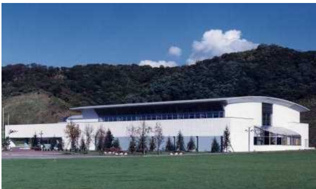
家庭用燃料電池が整備された市営温水プール
