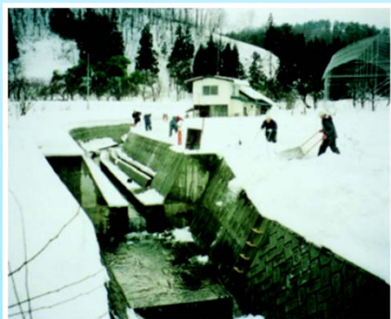
除排雪低水路（山形県村山市）
