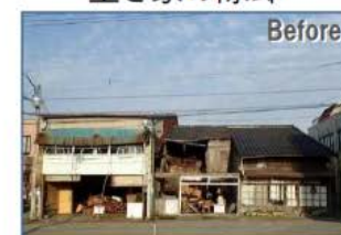
空き家の除却
