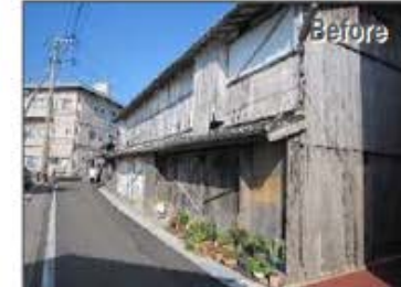
空き家の除却
