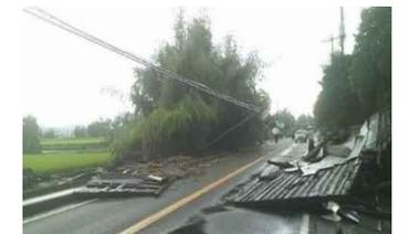
平成26年度の突風による電柱倒壊 (国道4号: 栃木県)
