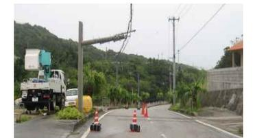
平成29年度の台風による電柱倒壊 (県道: 沖縄県)
