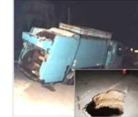
下水道の老朽化による道路陥没
