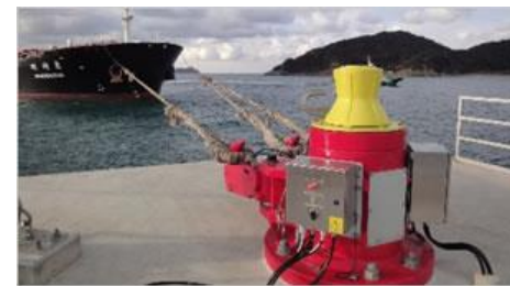
TRELLEBORG社の自動綱外し装置と係船モニター
