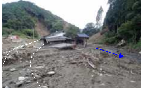
河道の埋塞状況
