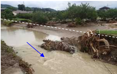
護岸の被災状況
