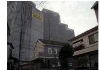
戸建て住宅地の高層マンション
