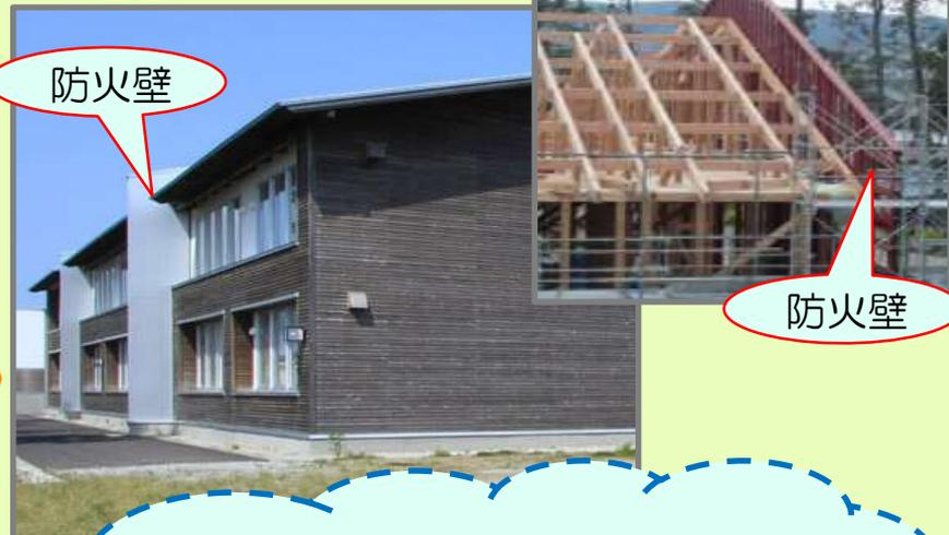
「壁」による区画を想定した規定であるため、1階を鉄筋コンクリート造とし、2階を木造とするなど、上下方向への延焼が防止される計画であっても、防火壁による区画が求められる。
