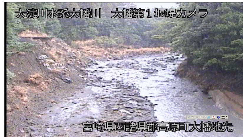
④ 大幡第1堰堤 平成30年3月5日 9:45現在
