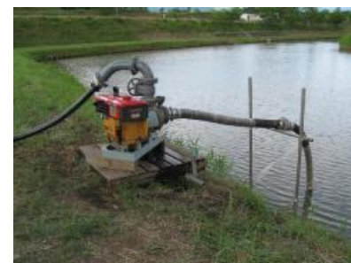
災害応急ポンプの設置事例
