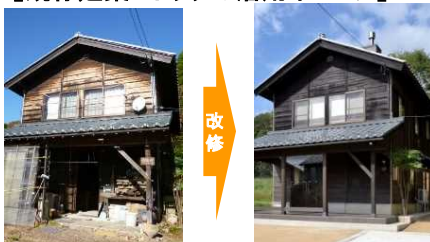
改修前(空き家) 改修後(グループホーム、飲食店、宿泊施設等)
